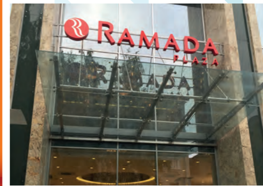
Козырек с подогревом над входной группой, г.Воронеж
