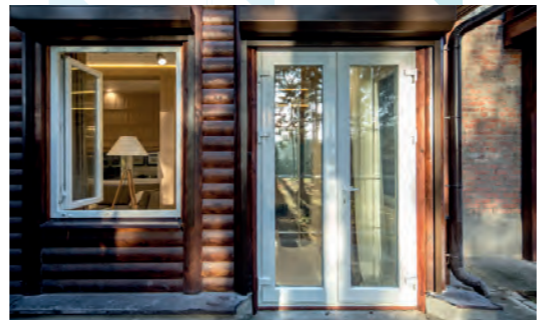
Установка греющих окон и двери, МО, г.Мытищи
